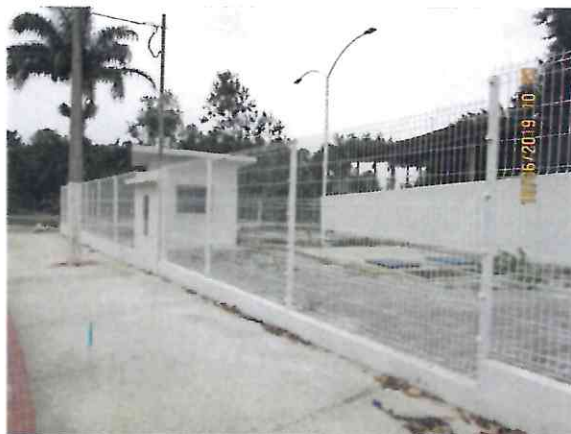
Elevatória Bairro Lagoa do Meio
