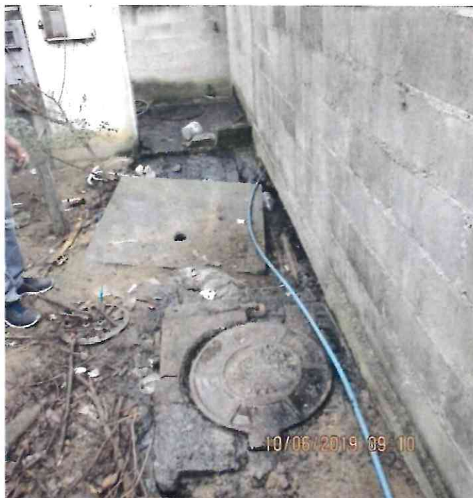
Elevatória Bairro Aviso
