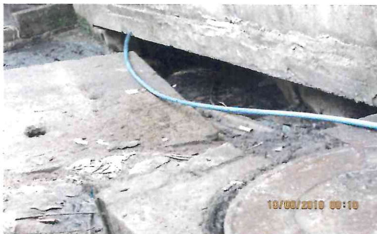
Elevatória Bairro Aviso
