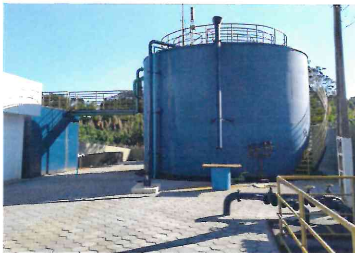
ETE Bairro Bebedouro
