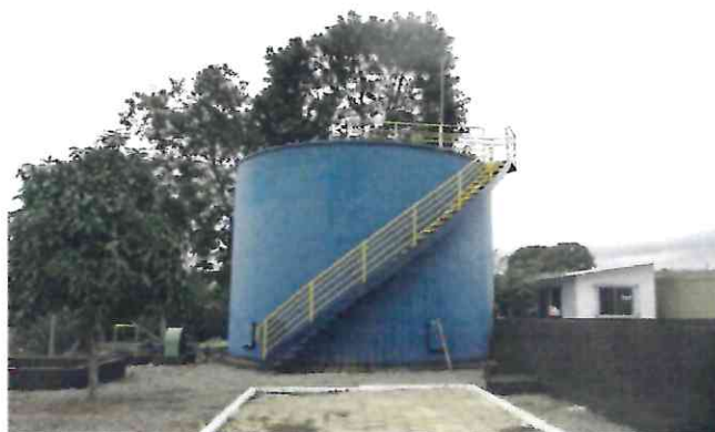
ETE Bairro Farias
