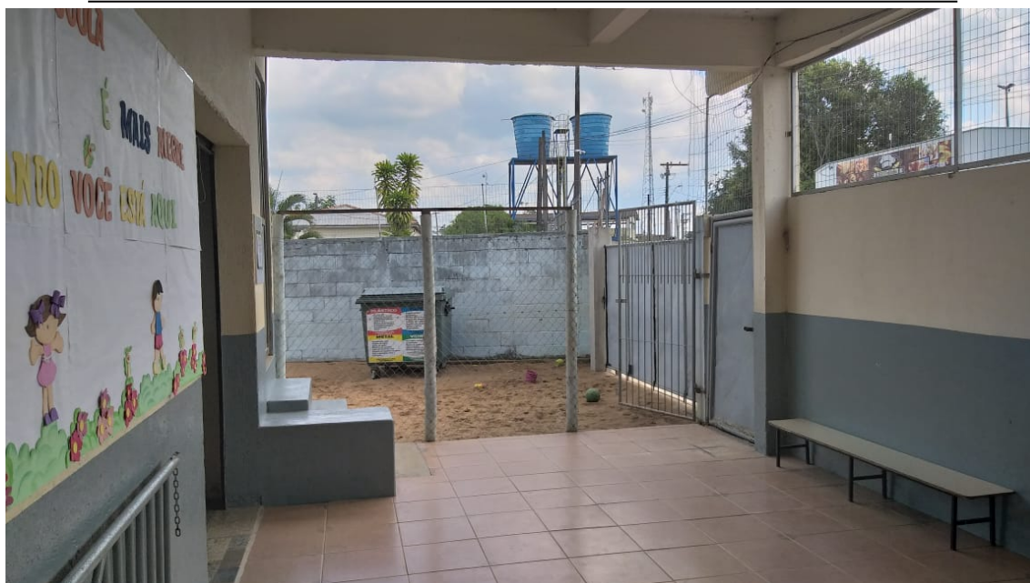
ENTRADA E ÁREA COMUM DA ESCOLA COM A CASA DO PISO SUPERIOR:
