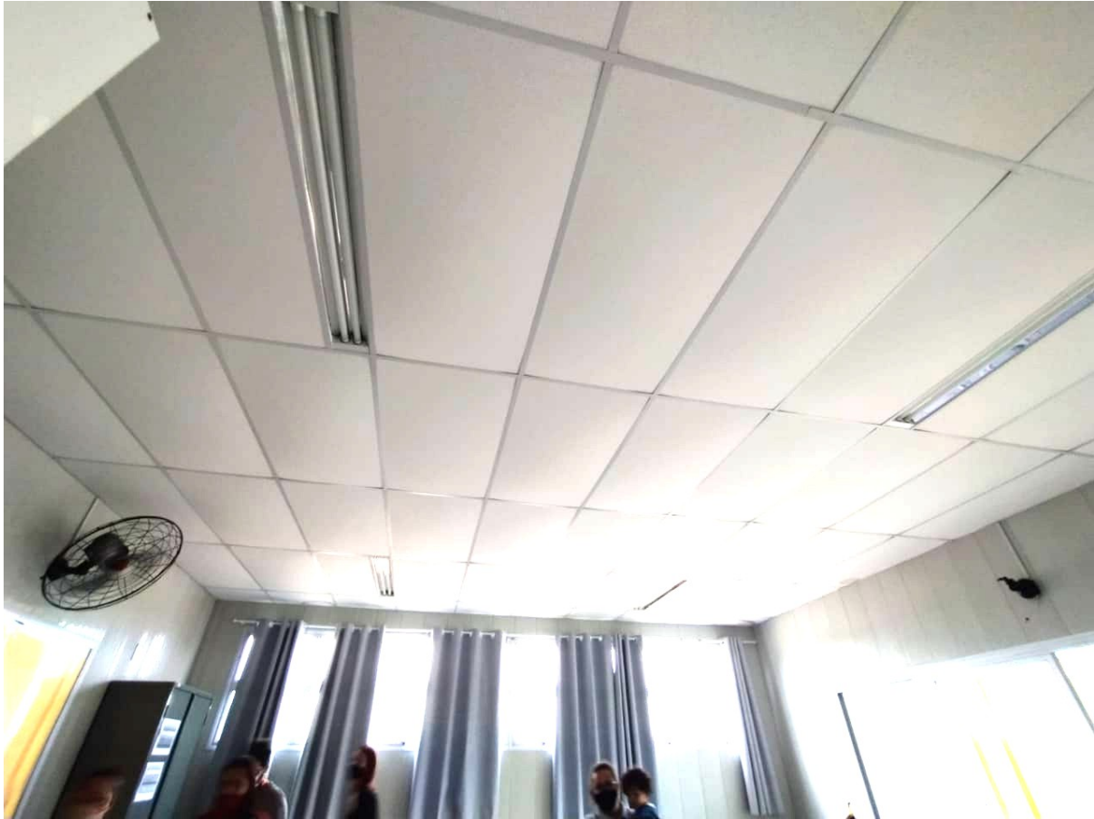
Sala de aula, com apenas 1 ventilador.
