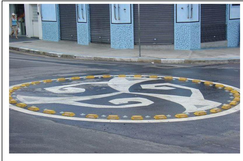
Figura 04: mini-rotatória com ilha central demarcada com sinalização horizontal.
